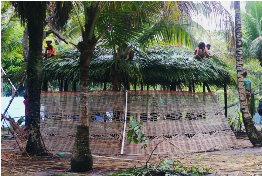
Processo de construção da Maloca Útero na Vivência Tupinambá promovida pelo Floresta Cidade em parceria com o Levanta Zabelê em Una no Sul da Bahia. Primeira construção da Universidade Útero Amotara Zabelê ou do Laboratório de Pesquisa Ancestral liderado por Yakuy Tupinambá. Realizada em janeiro de 2024.
